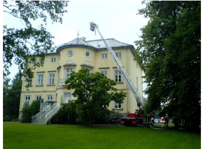
Dachstuhlbrand am 23.07.2009 im Herrenhaus Gut Rastorf. Das Feuer im Dachgeschoß wurde unter schwerem Atemschutz von Innen bekämpft. Über die Drehleiter wurde die Dachhaut geöffnet.
